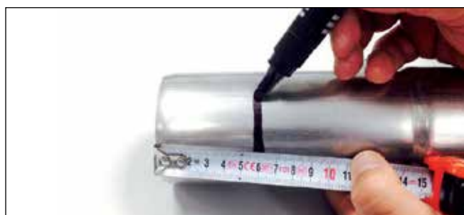
Figura 5 - Marcatura quota d'innesto
