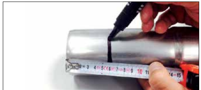
Figura 5 – Markierung der Einsattiefe
