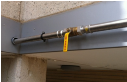
Fig. 35 - Instalación con pasamuros
