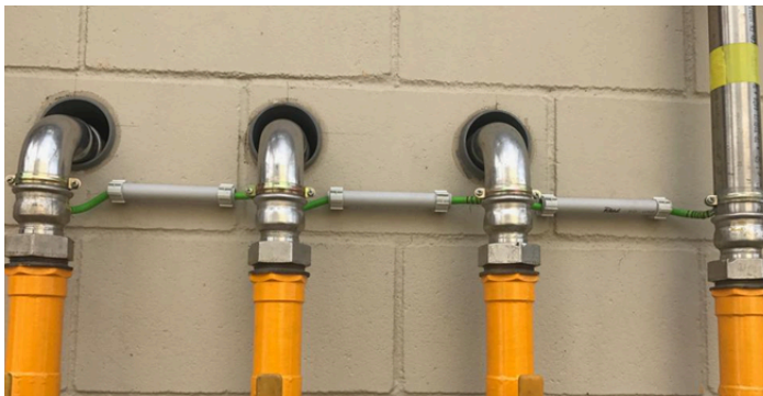
Fig. 38a - Instalación exterior alojada en vaina
