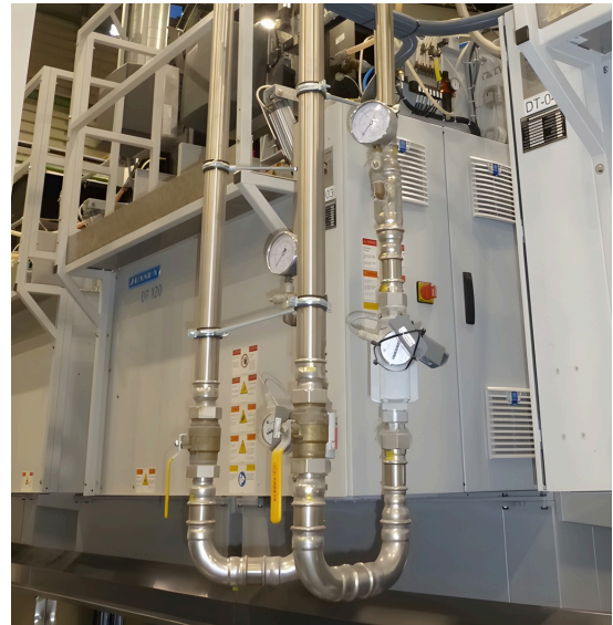
Fig. 5 - Instalación industrial de inoxPRES GAS
